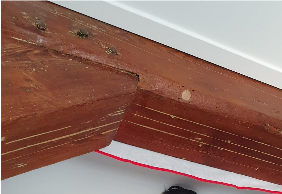
Richtlijnen waarbij de buitenste twee lijnen de breedte voor de pen-gat-verbinding aangeven.
