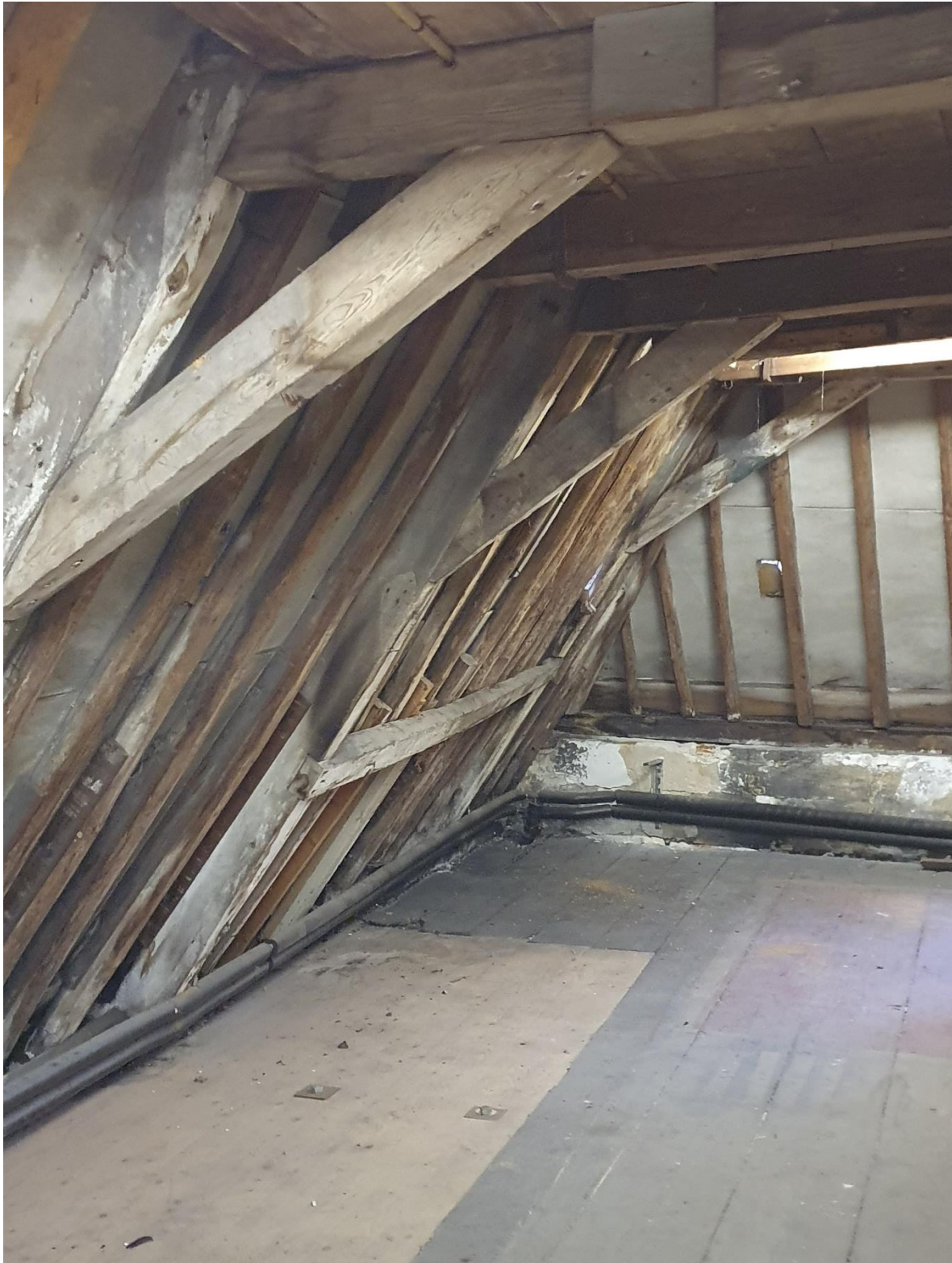
Spantconstructie met dubbele haanhouten waarbij over de onderste haanhouten een flering is gelegd, extra ondersteund door aan de flering opgehangen tussenbalken.
