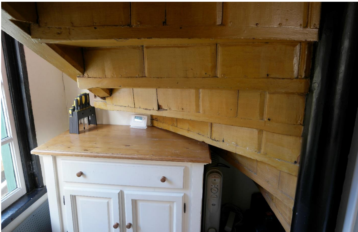
De achterkant van de noors grenen trap op de verdieping. Ooit liep de trap door naar beneden.
