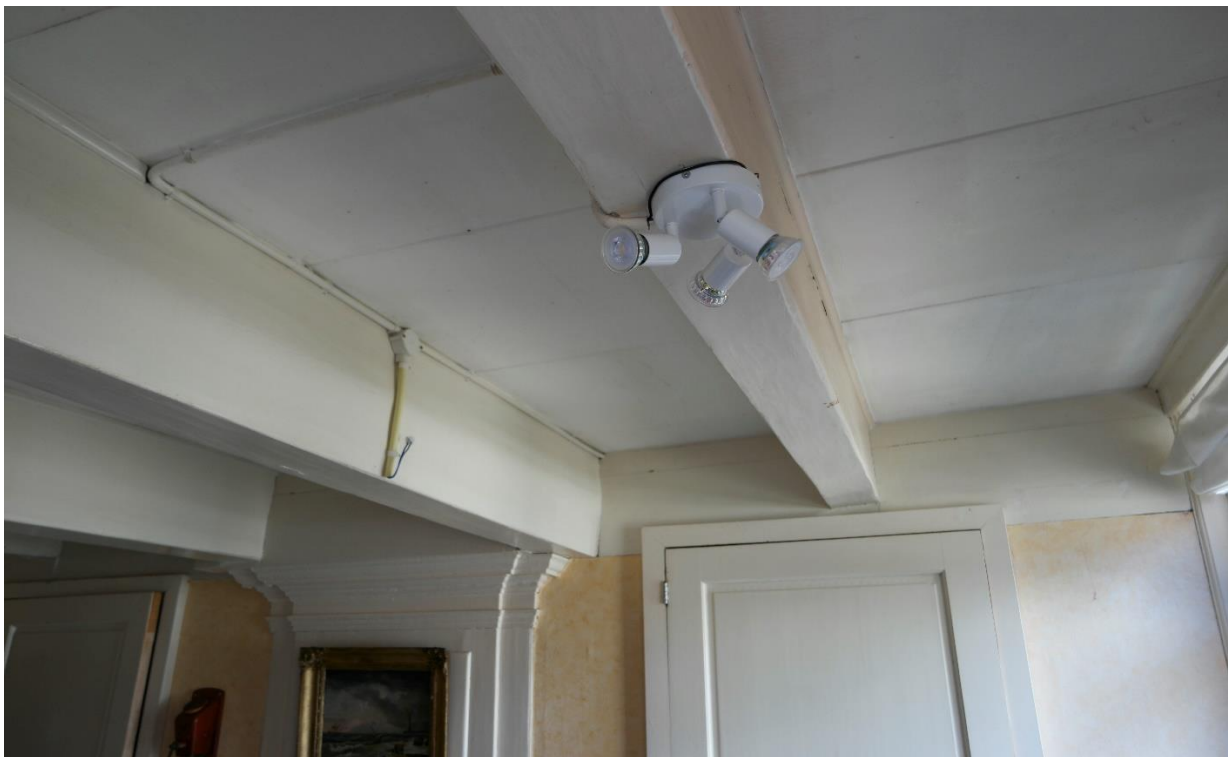
Noors grenen balkenlaag op de verdieping.
