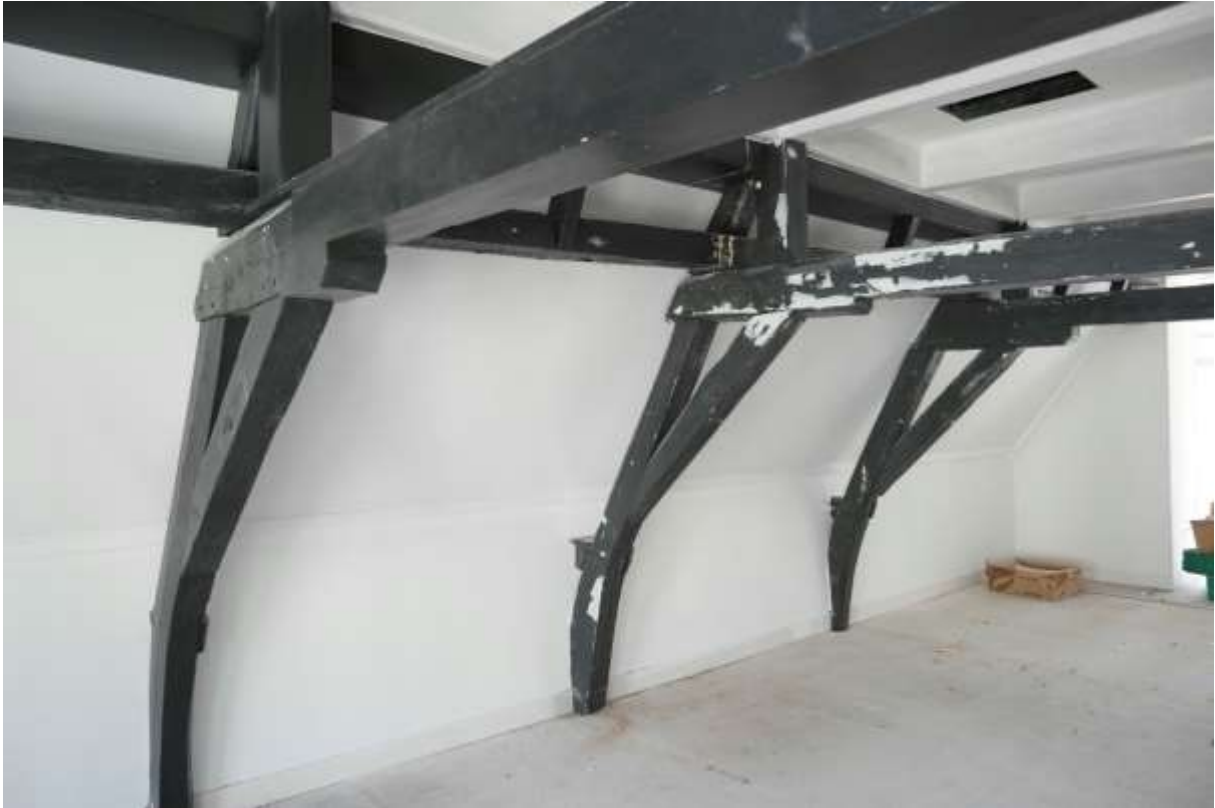
Eiken kromstijlen met blokkeels en grenen korbelen en dekbalken op de bovenverdieping van nr.19.
