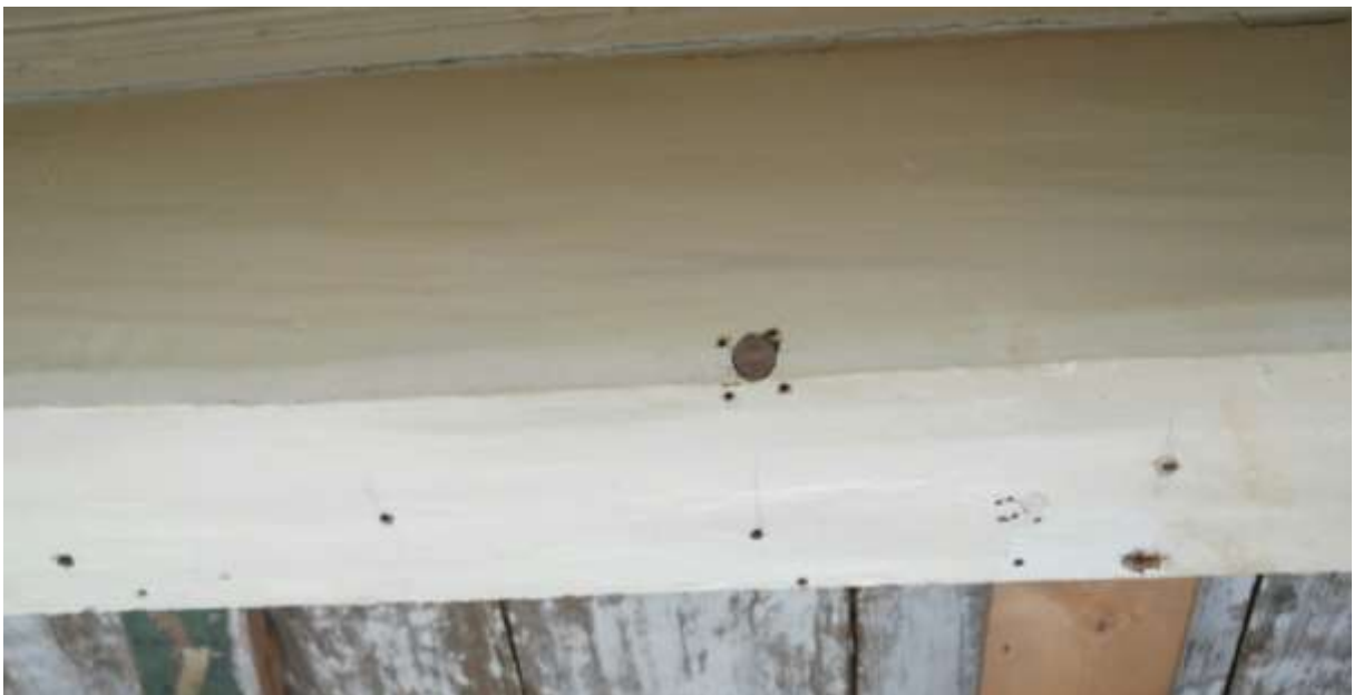
Boorgat in een grenenbalk met wan, de laatst gevormde jaarring van de boom.
